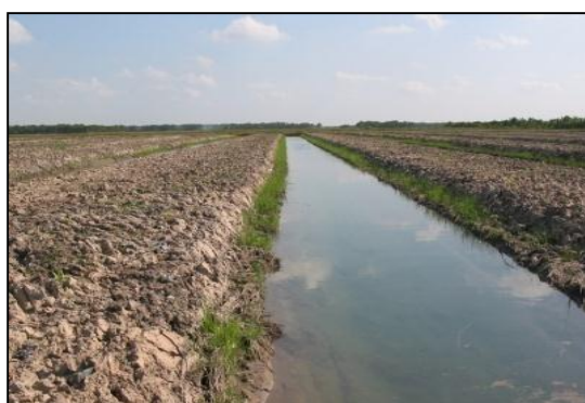
ภาพที่ 7-6 การทำคูระบายน้ำออกจากพื้นที่
